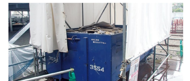
廃石膏ボード置き場
