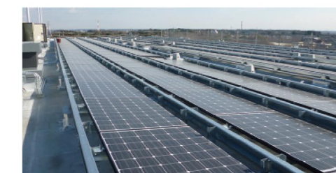
ソーラーパネルの設置状況
