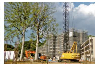
移植した既存樹を保護しながら工事を施工
