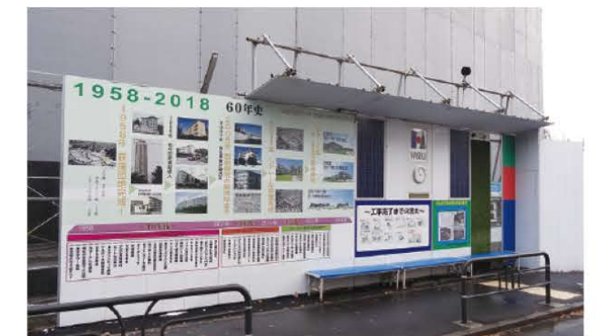
「シティテラス荻窪エアーズコート」新築工事作業所 仮囲い
