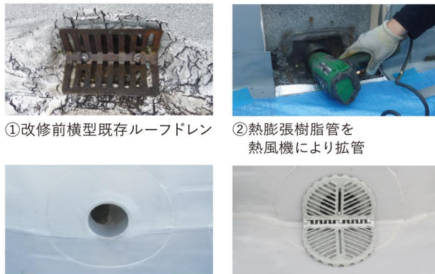
③ドレン開口部施工完了
