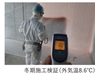
冬期施工検証(外気温8.6°C)
