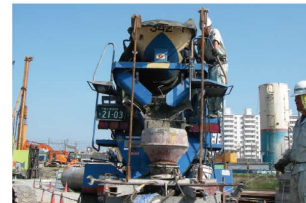
杭コンクリート打設
